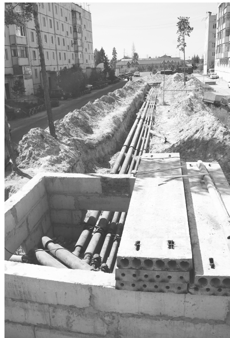
Ремонт внутриквартальных сетей водоснабжения в г. Муравленко
