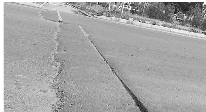
Еще один съезд с улицы Нефтяников - две плиты, по краям которых вместо заасфальтированных закруглений - глубокие ямы.
