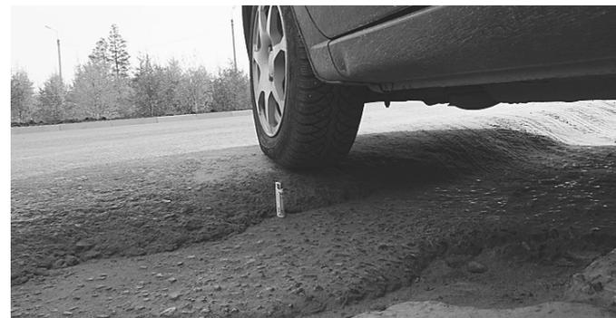
Пешеходный переход. Здесь уже вдоль трассы глубокие рытвины и высокие выступы, обозначенные даже деревянной рейкой.
