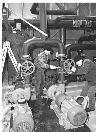
Бригада слесарей-сантехников выполняет работы по теплоизоляции нового оборудования на ЦТП-8 для снижения потерь тепловой энергии
