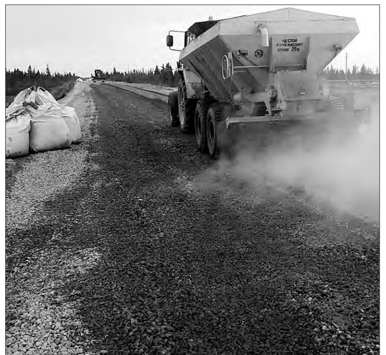
**Ресайклинг – метод стабилизации грунта, позволяющий вместо асфальтобетонного покрытия получить дорожное полотно переходного типа с улучшенными эксплуатационными характеристиками.**
