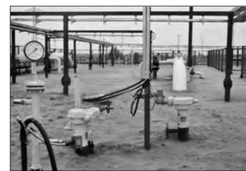
Проект предусматривает установку клапанов регуляторов на газопроводах высокого и низкого давления, которые в случае необходимости позволяют регулировать давление во внутриплощадочных газопроводах, не нарушая процесса подготовки нефти. Также предусмотрена установка сепаратора, который обеспечит стабильную работу газового оборудования котельных и печей.
