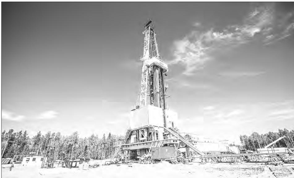
магниевою залежь, пришлось отклонять профиль относительно вертикали более чем на 3 000 м. При этом глубина скважины по стволу составила 4 540 м. В результате сложной, ранее никем в Пермском крае не исполнявшейся работы удалось открыть месторождение нефти, находившееся под залежами калийной соли. Всего, по оценкам специалистов, здесь находится более четырех миллионов тонн нефти.
