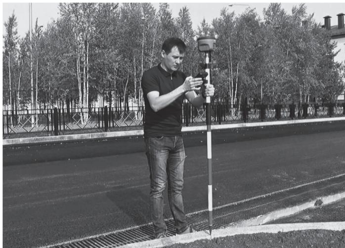
Геодезическое спутниковое оборудование определяет уровень высоты и толщины материалов / ФОТО НА ПОЛОСЕ ИЗ АРХИВА «МУРАВЛЕНКО МЕДИА»
