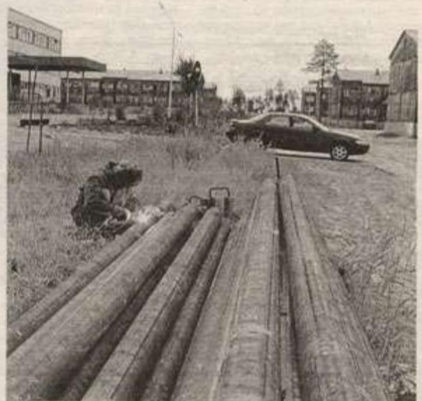
Идет подготовка пiletей труб диаметром 159 и 219 мм (СШ № 1)
