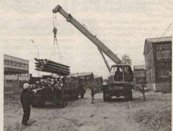
Из БПО (базы производственного обслуживания) привезли подготовленные к монтажу трубы (СШ № 1)
