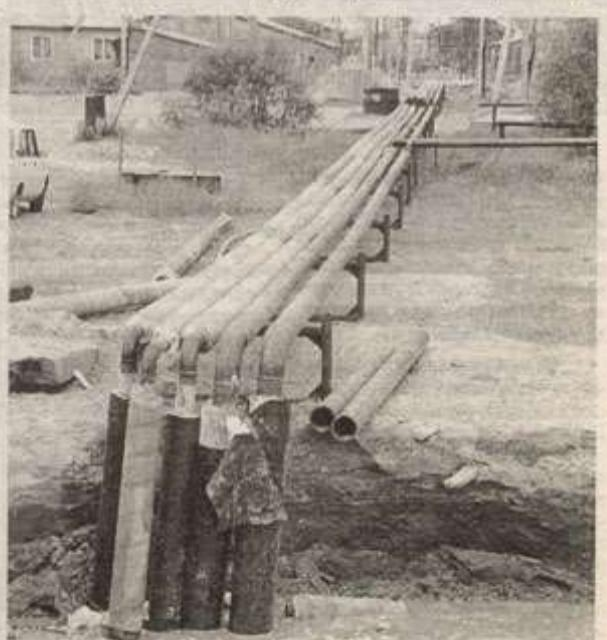
В микрорайоне № 5 сети ТВС решено пустить по поверхности, так надежнее. Здесь очень близко вода, кроме того, на ускорение коррозии участка, в случае подземной прокладки труб, будет влиять близость электрокабелей
