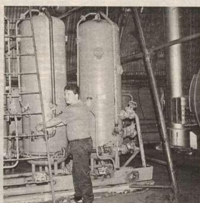
Наладка смонтированной химводоочистки на котельной № 1. Слесарь по ремонту котельного оборудования А. В. Ефименко
